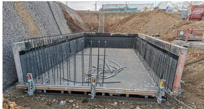
Dieses Produkt ist konzipiert für die vertikale Abdichtung. Es besteht aus einem leistungsstarken SBS modifizierten Bitumen auf einem ultra hochfesten Kompositrträger. Die Unterseite ist selbstklebend und geschützt mit einer Silikonfolie. Die Oberseite ist mit Spezialsand abgestreut. Die Überlappung ist mit einer Duo – Rand Technologie ausgestattet.
